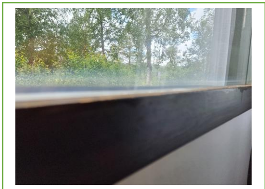
Bild 1: Punktering på altandörr
