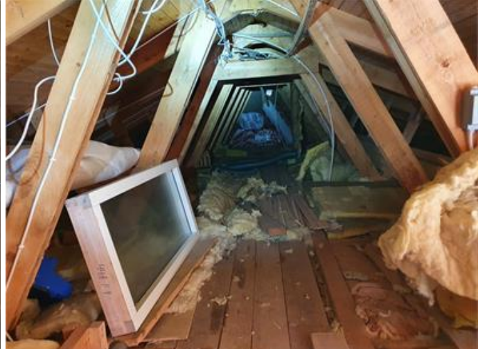
Utrymmet på vinden
