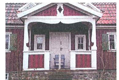
Vålbevarad sommarvilla på Magnarp 7:33. Faluröd lockpanel med vita foder, knutar och vindskenor. Källare på hög stenfot. Liten kupa. Veranda på framsidan.
