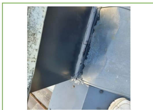
Bild 6: Äldre takgenomföringar.
