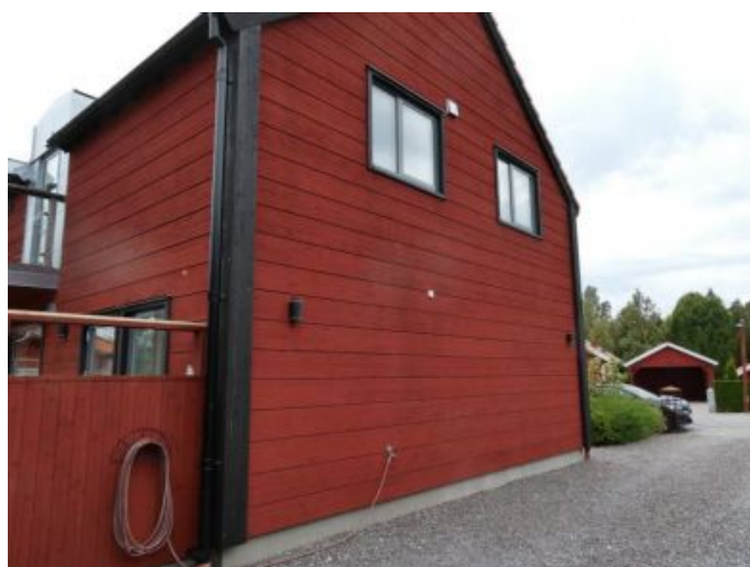
Fasader och fönster
