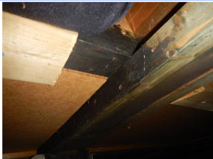
Delar av bjälklag krypgrund rötskyddsbehandlat.
