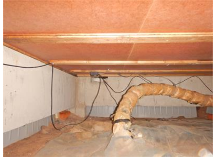
Installation av "Trygghetsvakten" med kablar i kryputrymmet.
