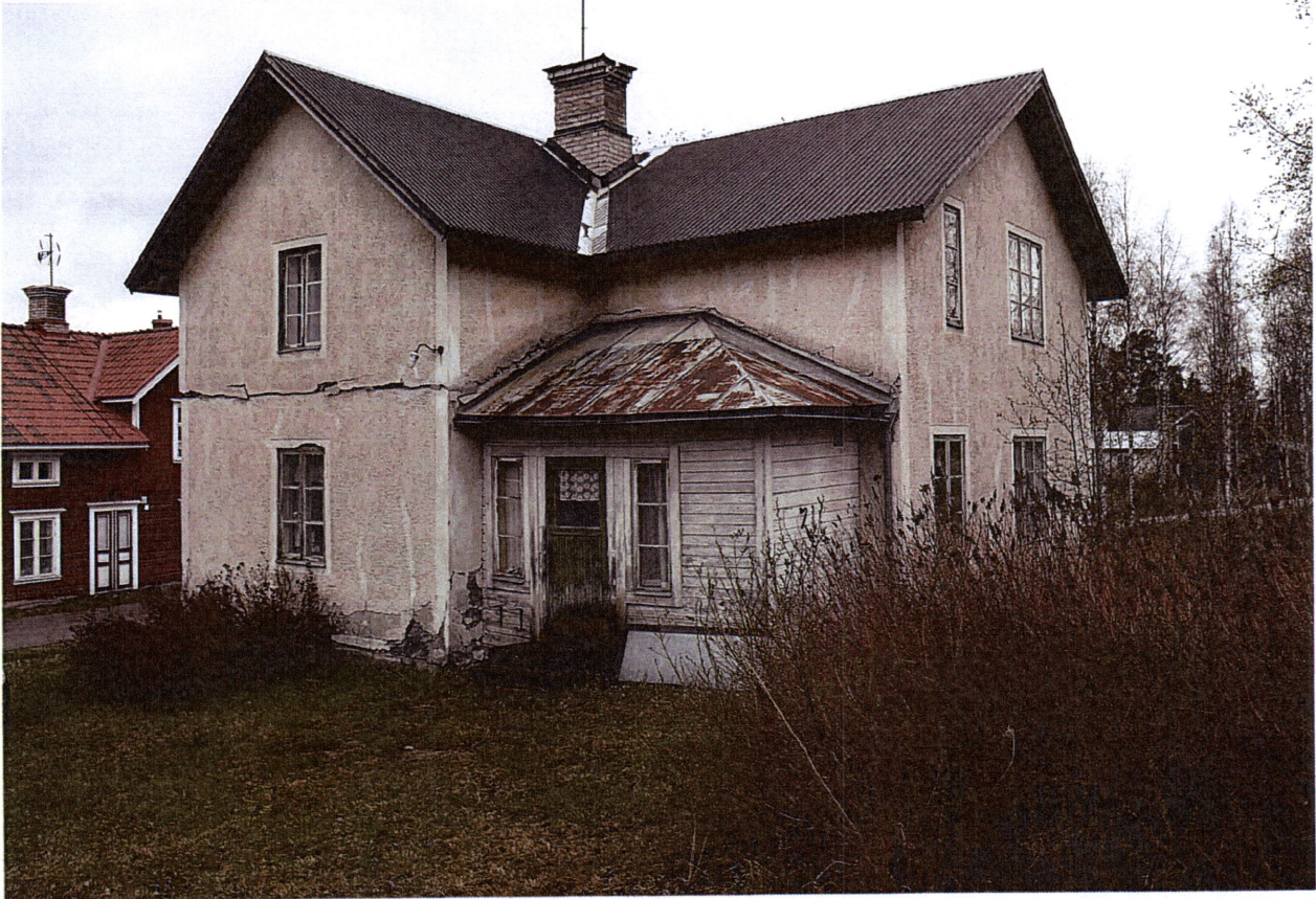
FÖRRÅDSBYGGNAD (NR 14 PÅ KARTA)
