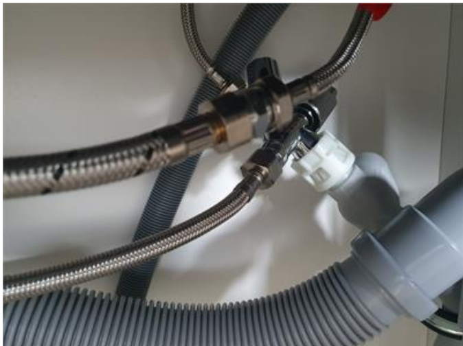
Rör under diskbänk bör förankras
