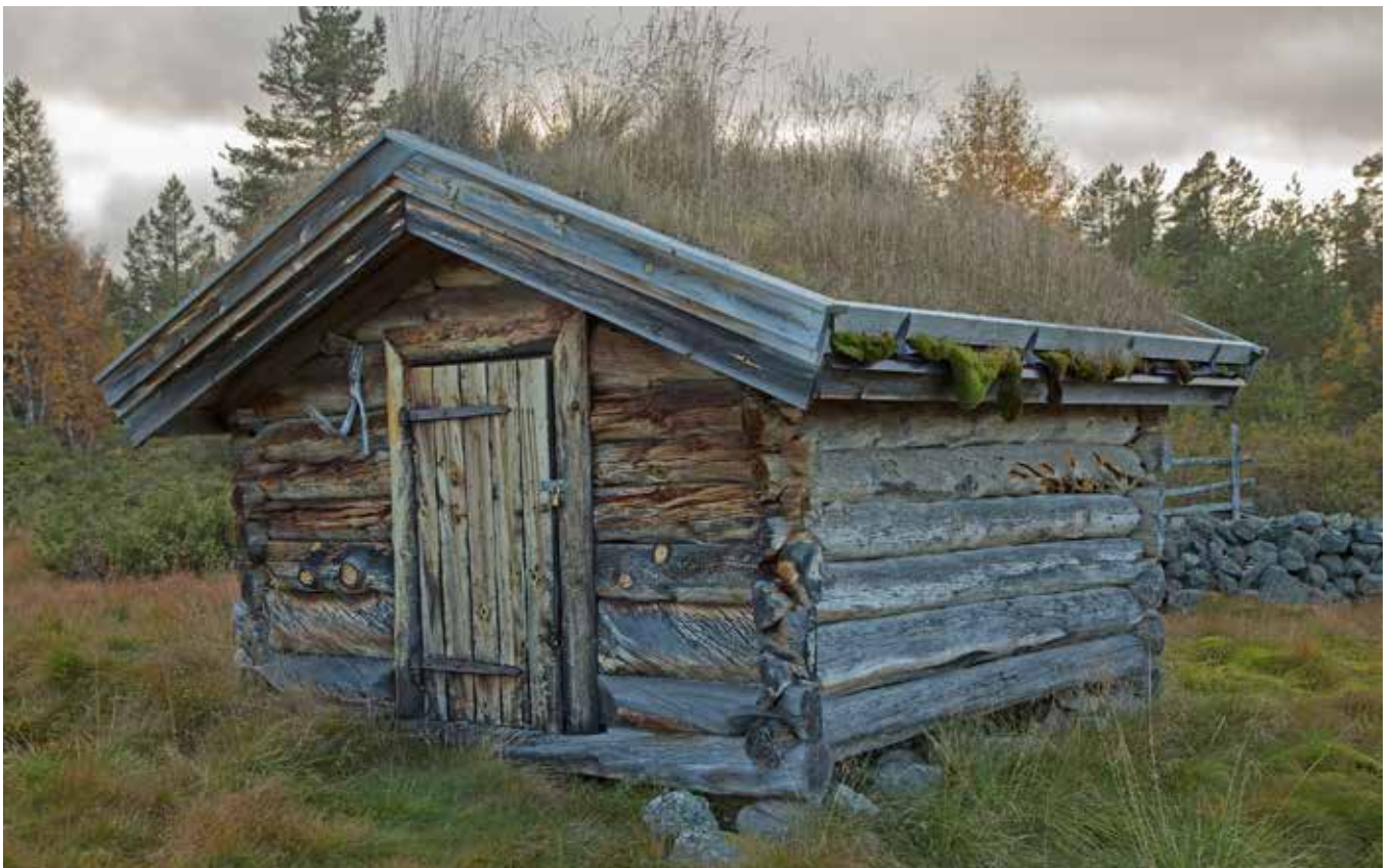
Förrådsbyggnad på Grunddagssäterns fäbod delvis timrad av torrfura.
