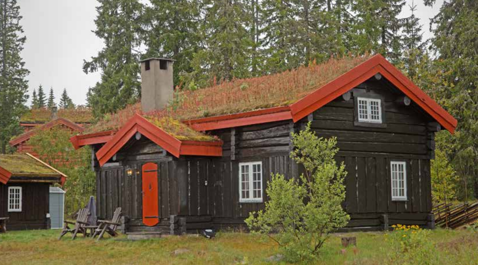
Även till mindre byggnader kan trä användas på flera olika sätt. Okantad panel, timmer, symetrisk fönstersättning och aldrig ett spetsigt fönster. Foto från Trysil.
