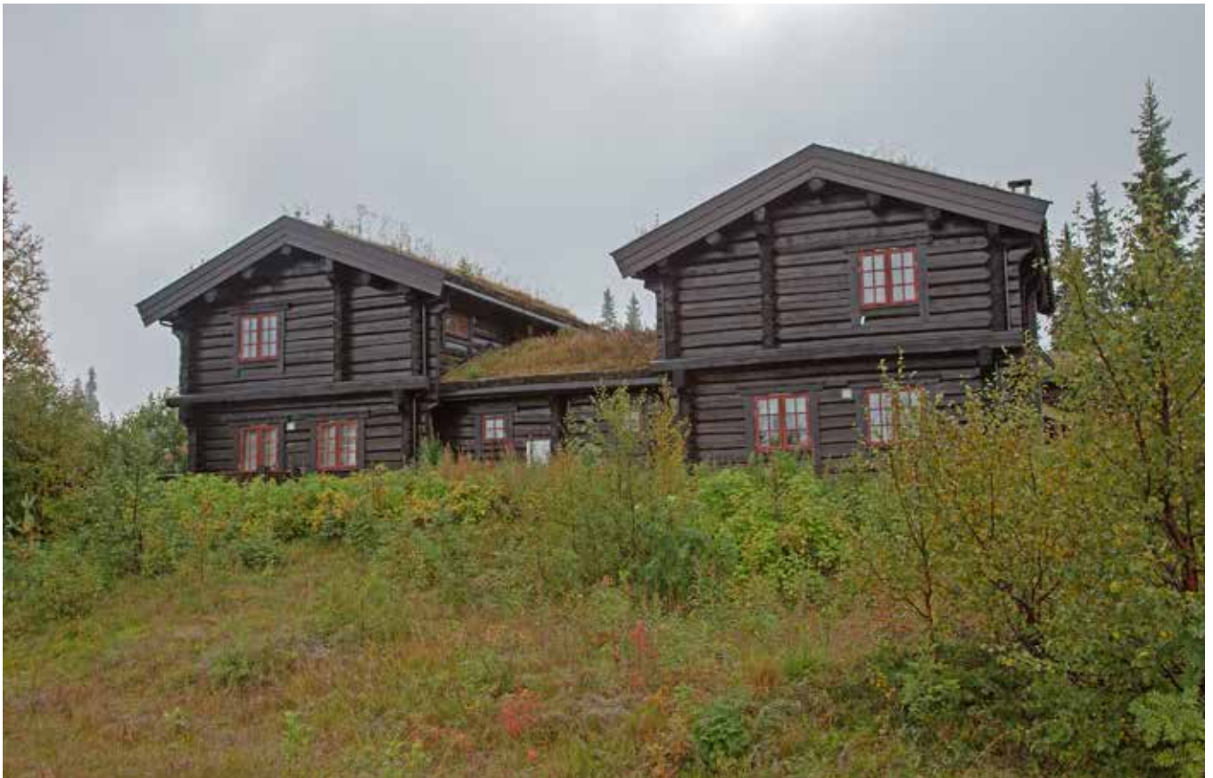
Utkragad övervåning ger ett småskaligt intryck trots en stor byggnad. Symmetrisk fönstersättning. Foto från Trysil.
