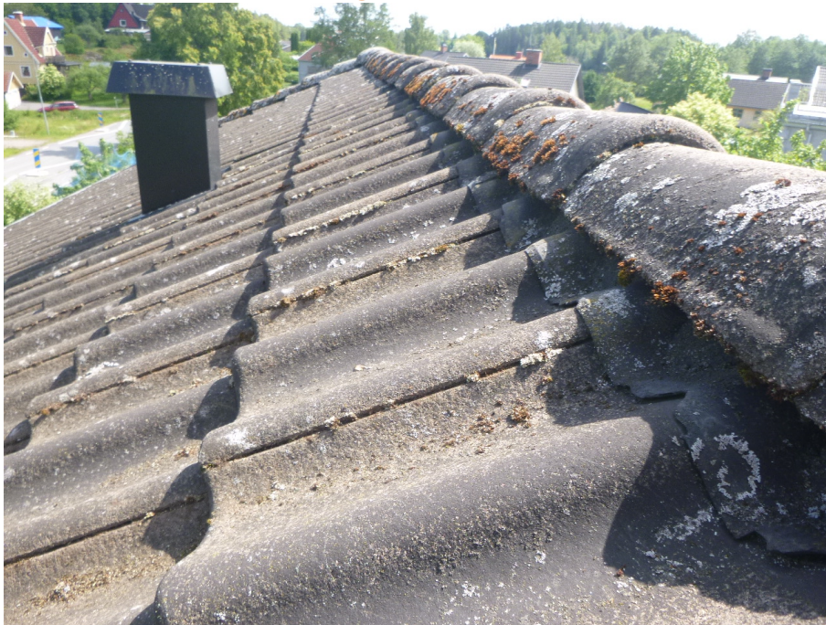
Nocktätning, yttertak.
